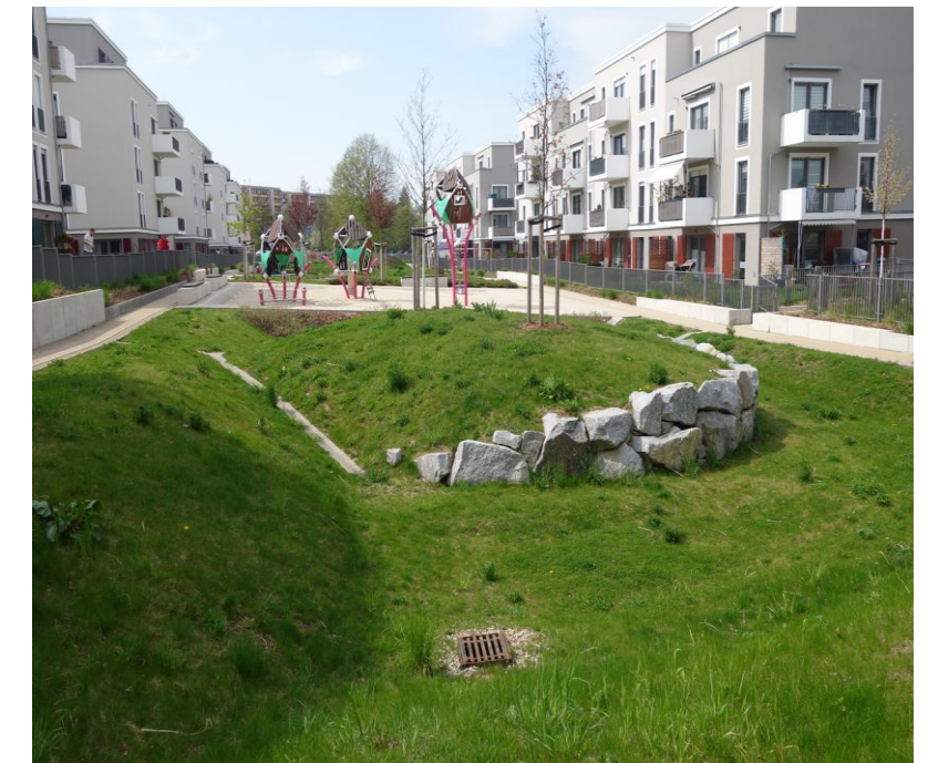
Retentionsmulden im Außenbereich der Häuser in der Kräutersiedlung Dresden-Gorbitz © Foto: Steffi Förtsch/SMEKUL
