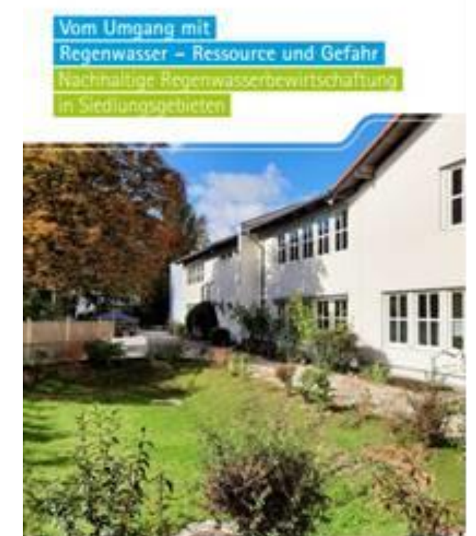
Multifunktionale Regenwasserrückhalte- und Versickerungsanlage Regenbogenschule Taucha
